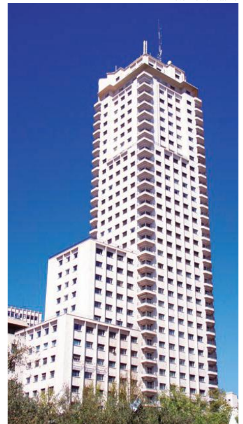
Foto: Torre Madrid
