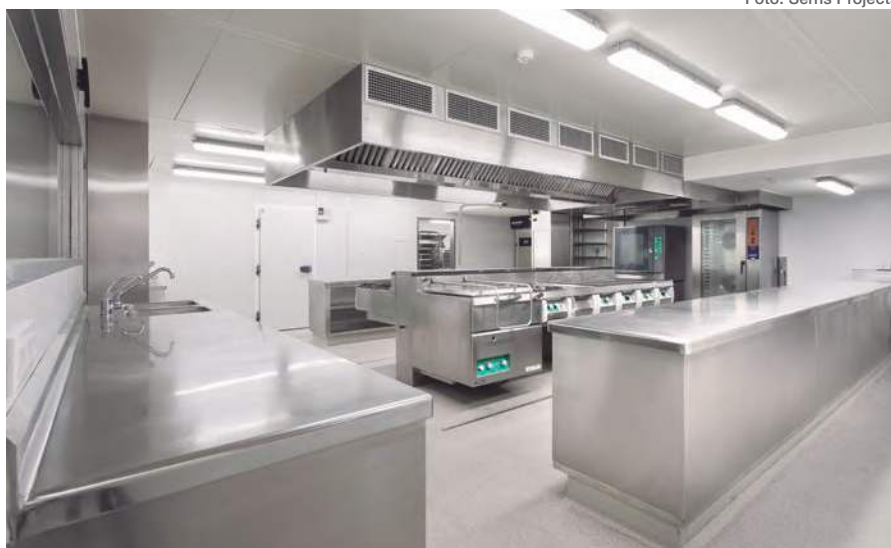
Foto: Serhs Projects
