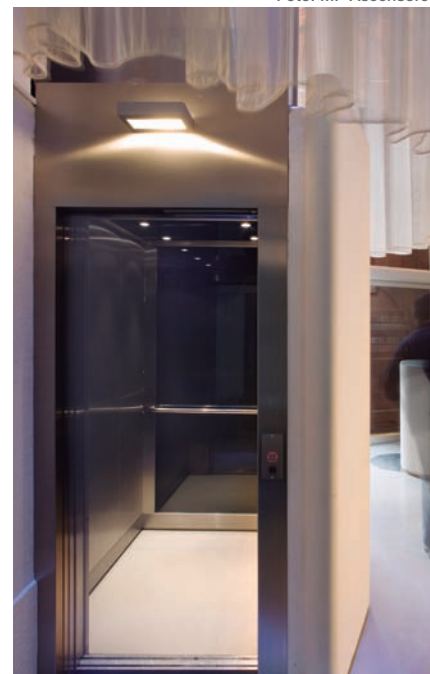
Foto: MP Ascensores
