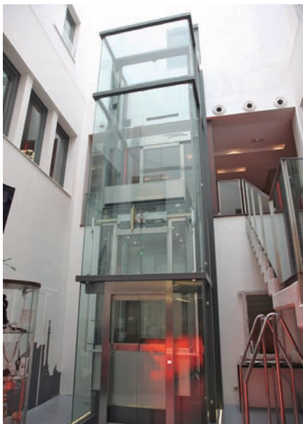
Foto: MP Ascensores
