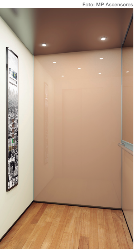
Foto: MP Ascensores
