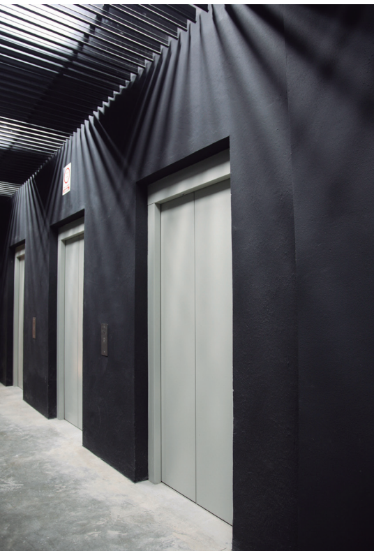
Foto: MP Ascensores
