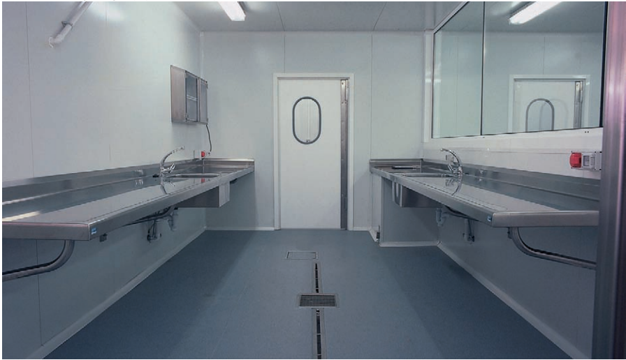
Foto: Serhs Projects y Equipment - Equipturis
