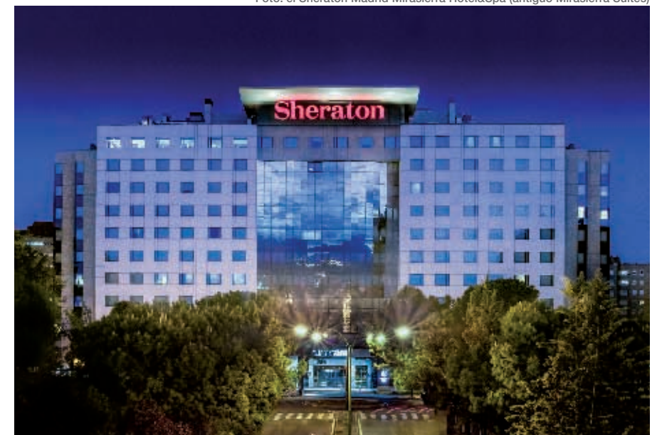
Foto: el Sheraton Madrid Mirasierra Hotel&Spa (antiguo Mirasierra Suites)
